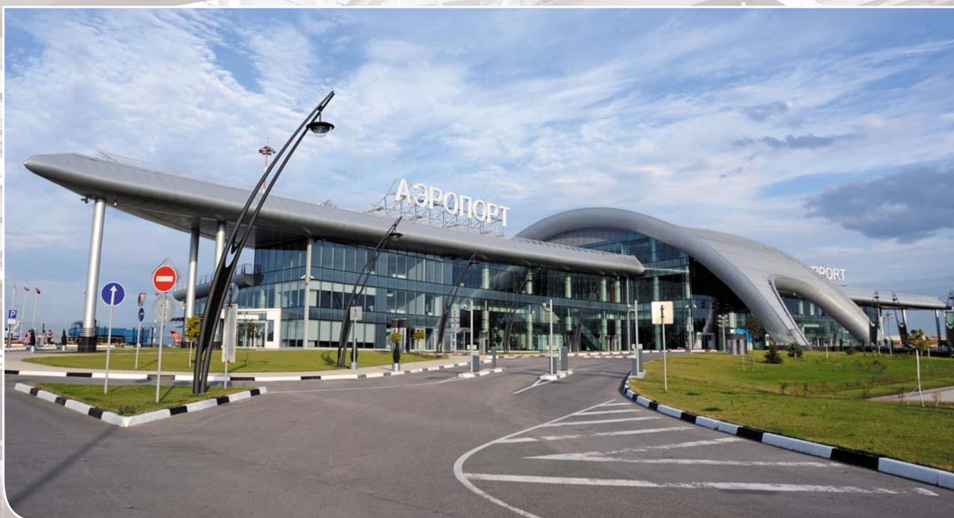
Международный аэропорт г. Белгород, 2013 г. Разработка проекта и изготовление металлоконструкций.
