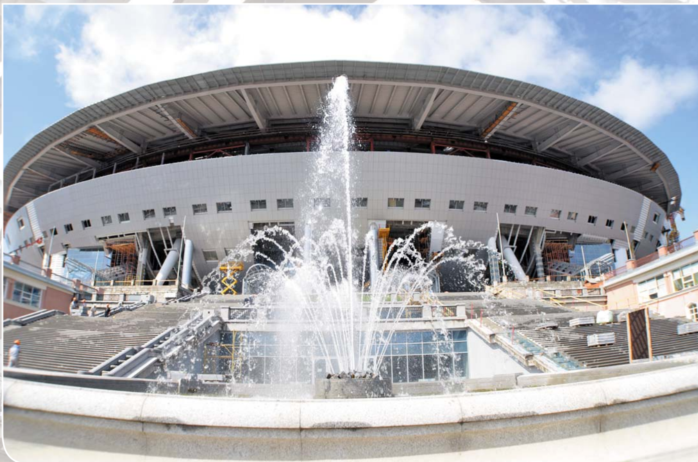
Стадион «Зенит-Арена» г. Санкт-Петербург, 2014 г. Изготовлено 10 000 тонн металлоконструкций.
