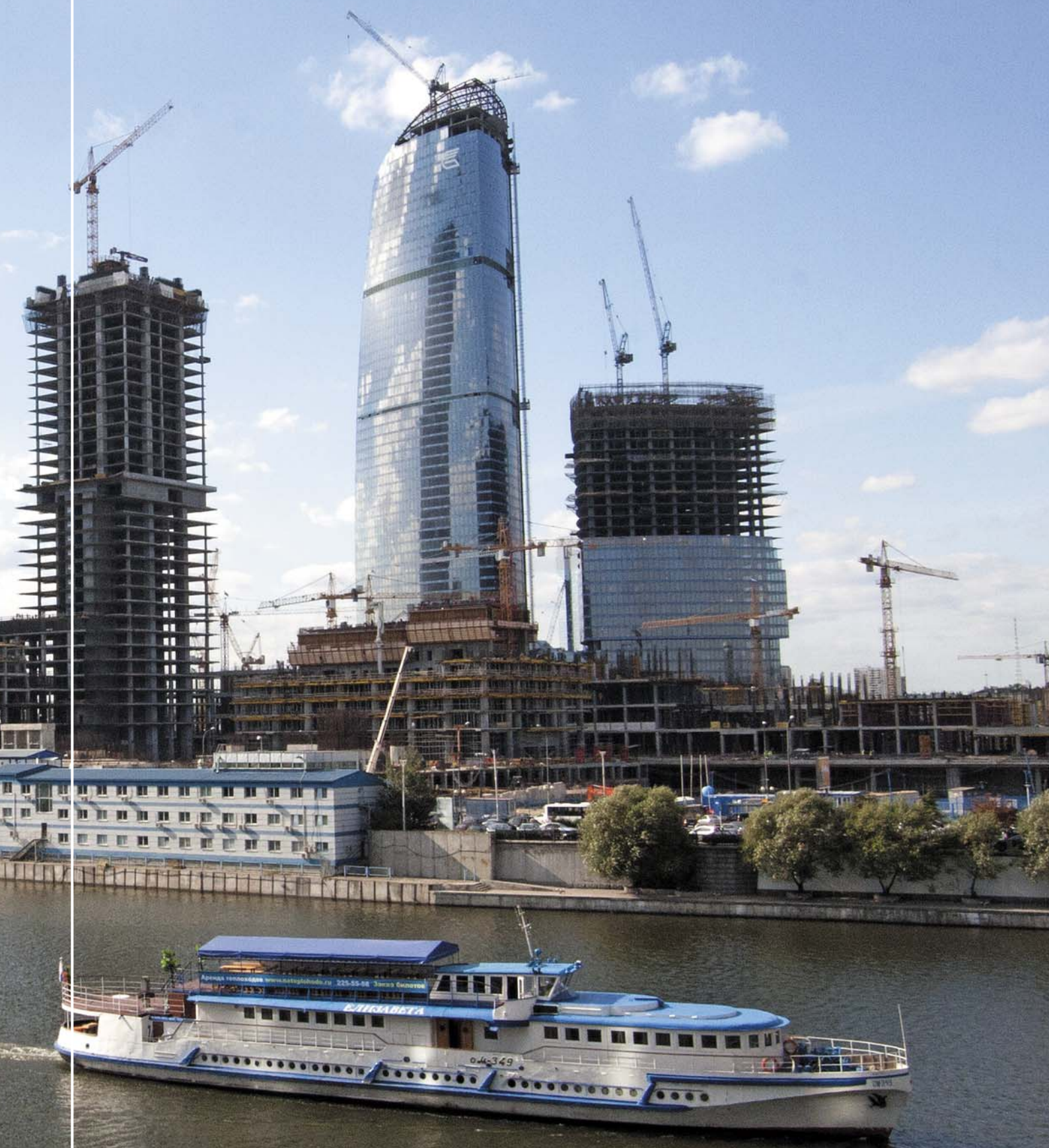
Башня «Федерация», г. Москва. Объем изготовленных металлоконструкций – 6 150 тонн.
